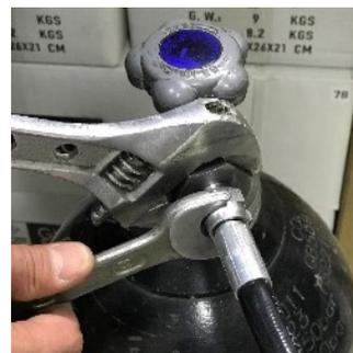
6. Подключите шланги CO2 высокого давления к баллонам. Резьбовое соединение затягивайте «от руки» до упора, затем используя **два** гаечных ключа No22 и No36 (либо 32), затяните резьбовое соединение с небольшим усилием.
